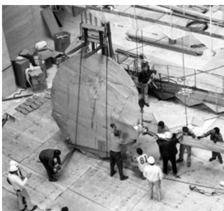
Proceso de montaje de la obra White Cascade. Alexander Calder. Mayo de 1976.
